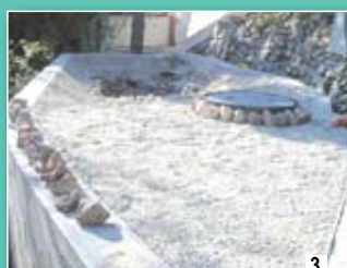
3 Réalisation de la filtration
