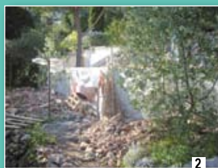
2 Réalisation d'un mur de soutènement
