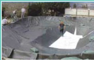
Mise en place de l'étanchéité
