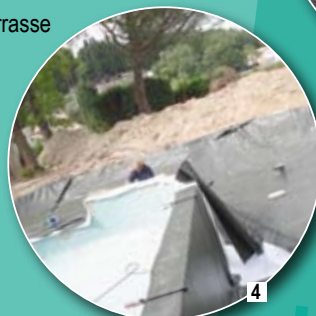
4 Mise en place de l'étanchéité et pose de l'hydraulique
