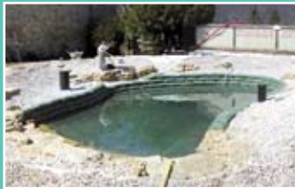
Mise en place de l'hydraulique et mise en forme du bassin
