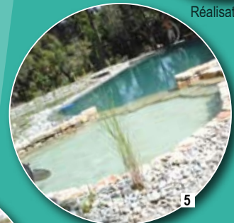
5 Mise en eau
