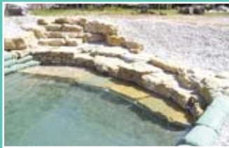
Réalisation des marches en rochers
